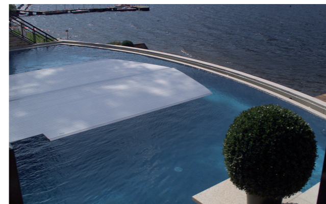
Das ganzjährig beheizte Außenbecken verfügt über eine zweiteilige, mittig im Becken unterflur montierte Rollladenabdeckung von grando (www.grando.de). Ist die Abdeckung geschlossen, wird der Wasserstand automatisch soweit abgesenkt, bis die Rinne trocken ist, um unnötige Wärmeverluste zu vermeiden.
